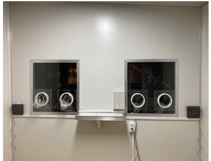
부스 내부 글로벌월 설치 모습
